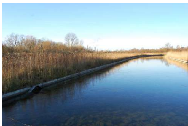
Figur 8. Den landskabelige kanal som forbinder Grønjordssøen med voldgaven ved Faste Batteri. Kanalen har ingen bredzone og det er vanskeligt for padder at forcere kanalen, da der er langt mellem "opgangene".
